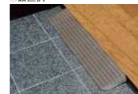
玄関(あがりかまち)の段差
